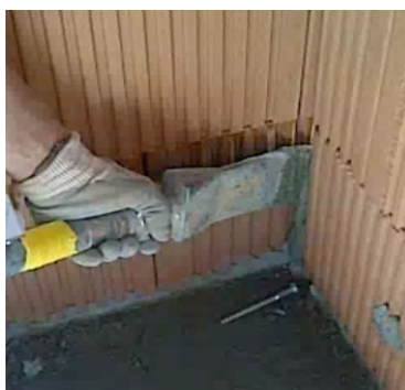
Figure 8 : « Bec » de collage des joints verticaux
