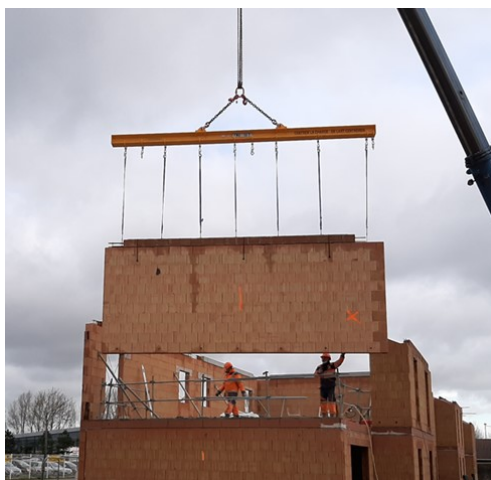
Figure 5 : Levage au palonnier spécifique
