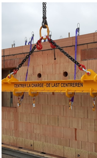
Figure 11 Broche d'ancrage en pied de mur
